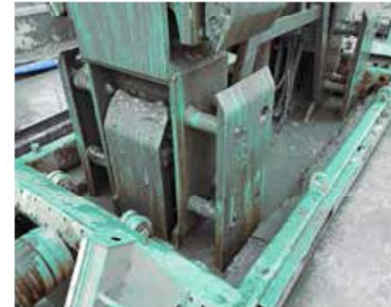
“二期槽”的开槽导向的配套装置
