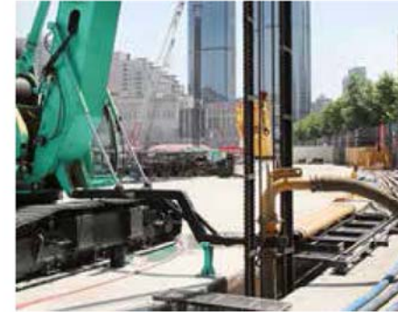
油缸控制，用于扶正排渣管的装置
